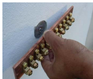
Figura 58: Modelo de derivações do aterrainsert
