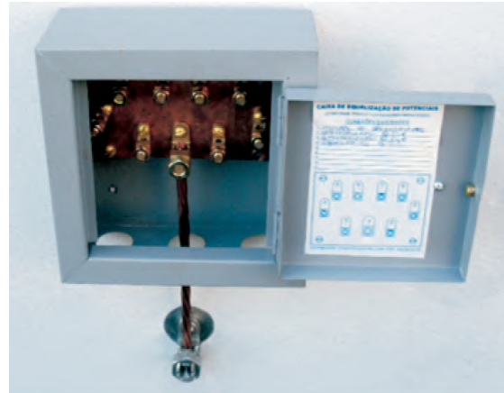
Figura 54: Interligação da caixa BEP com o aterrinsert
