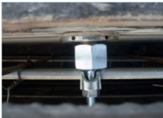
Figura 57: Instalação do aterrainsert em rebar na caixa 2
