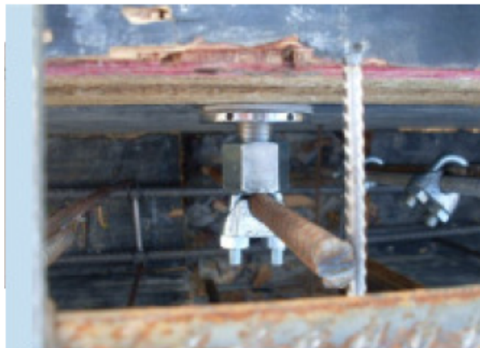
Figura 56: Instalação do aterrinsert em rebar na caixaria
