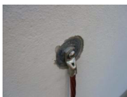
Figura 57: Instalação do aterrainsert em rebar na caixa 2
