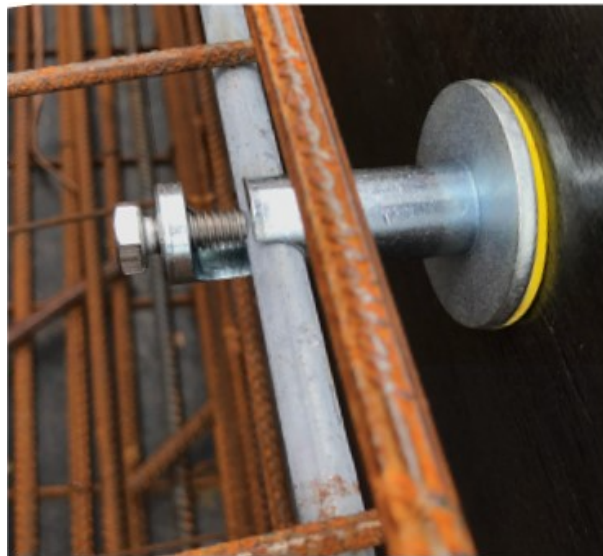
Figura 45: Aplicação de Aterrinter em caixaria
