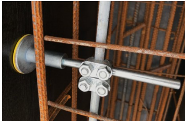
Figura 46: Aplicação de Aterrinter em caixaria 2
